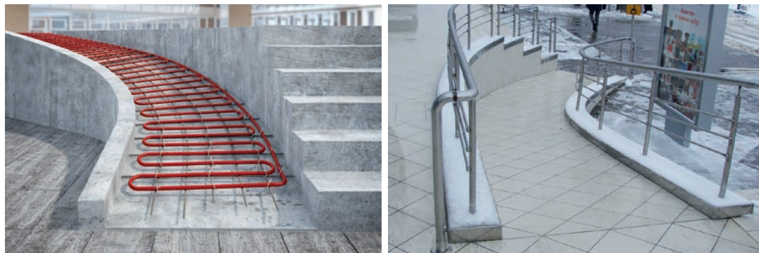
Рис. 41. Подогрев открытой поверхности Системы KAN-therm – в процессе и после окончания работ
