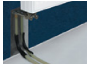
(с трубкой Cu \varnothing 15 ) к вентильному угловому узлу
