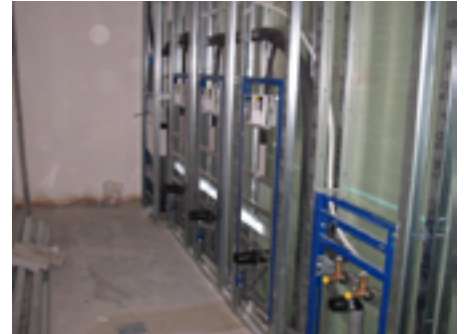
Монтаж умывальников в ряд «сухим» способом
