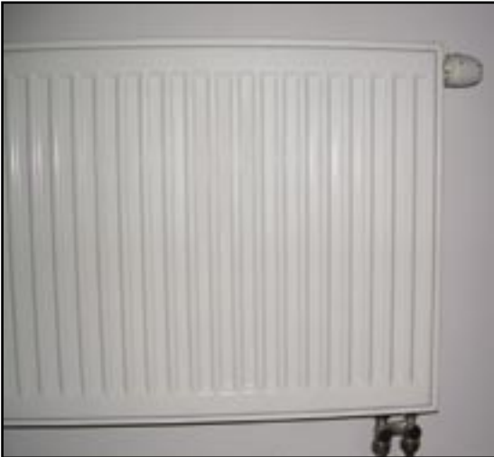
Рис. 11.9. Панельный радиатор с терморегулирующим узлом нижнего подключения Герц 3000
